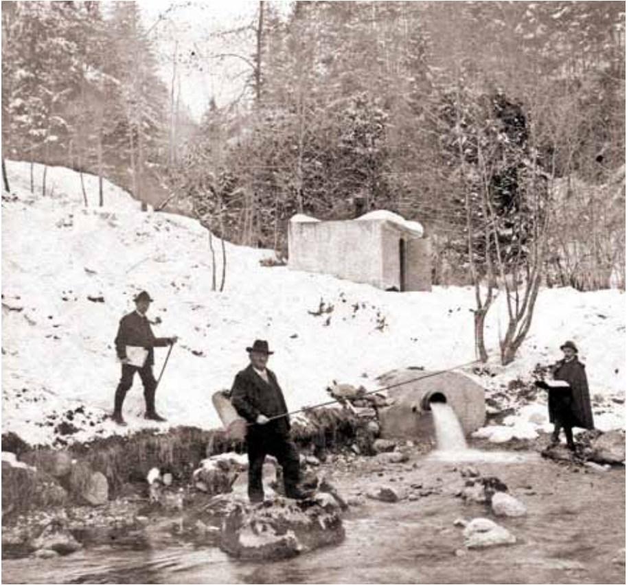
Bauleiter vor Sammelbunnenstube
