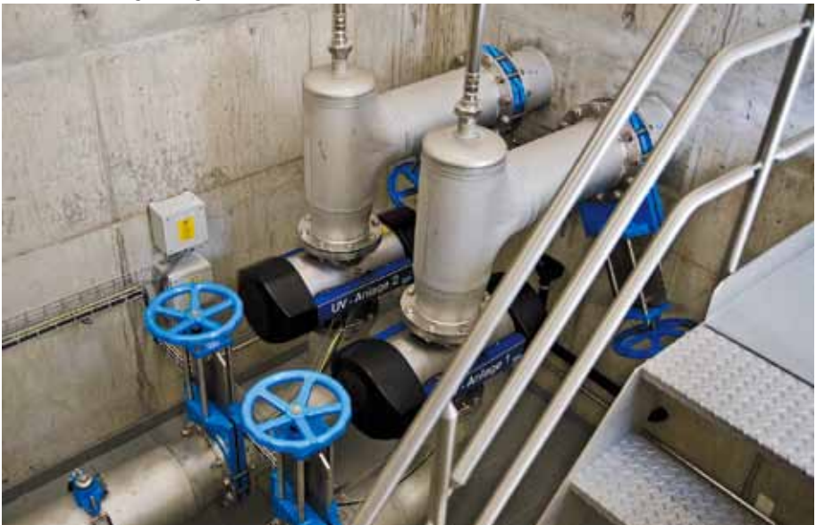
UV-Entkeimungsanlage
