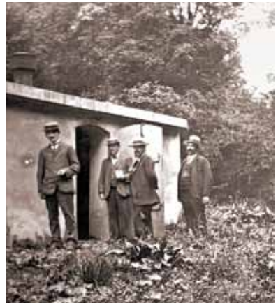
vor der Sammelbrunnenstube
