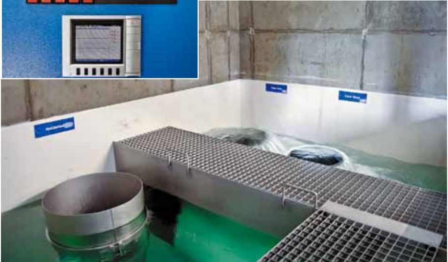
UV-Entkeimungsanlage
