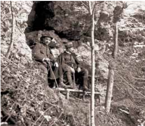
Bauleiter Ingenieur Bosshard (rechts)
